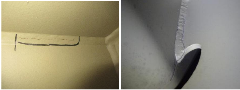
图 A.0.5 裂缝照片示例
